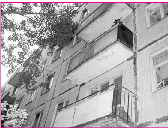
ул. Ленинградская, дом 15. Эта береза нарушает инсоляцию квартир
