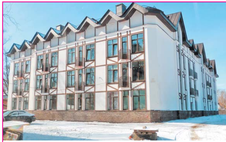
В этот новый дом на ул. Константиновская переехали 14 всеволожских семей из аварийного жилья
