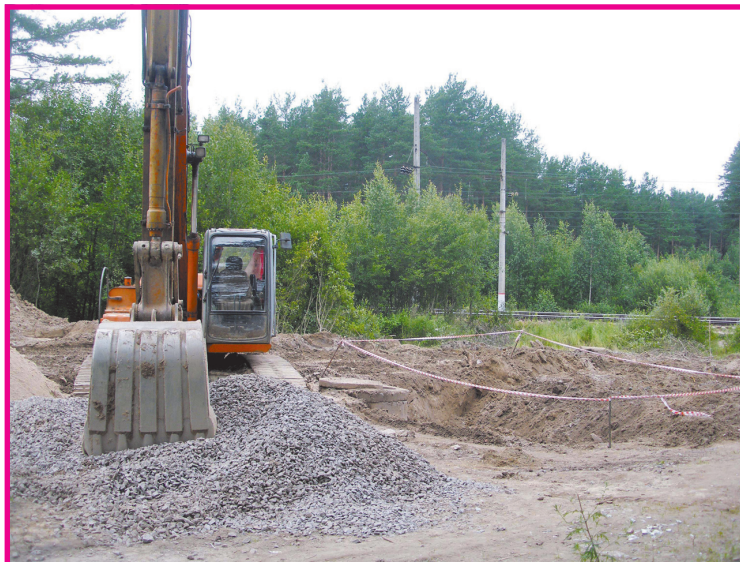
Строительные работы на участке Колхозная — Боровая начались
