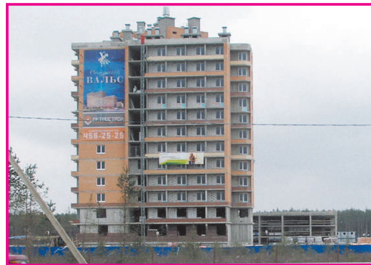
Стройка на Дороге жизни
